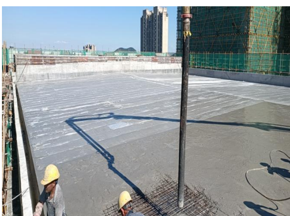
(B楼屋面混凝土浇筑)
