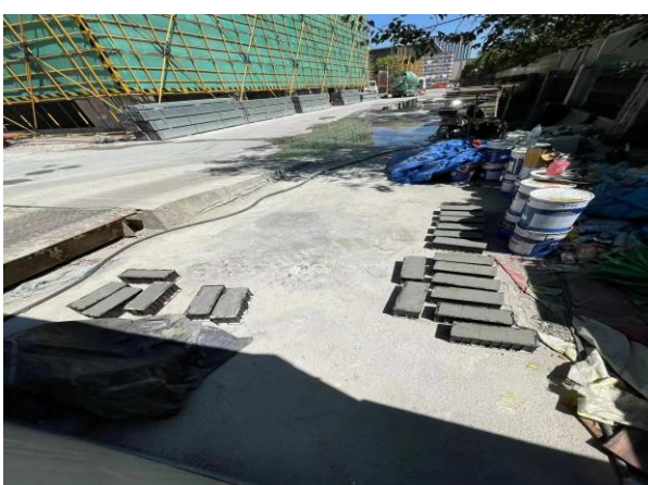
(混凝土试块留置)
