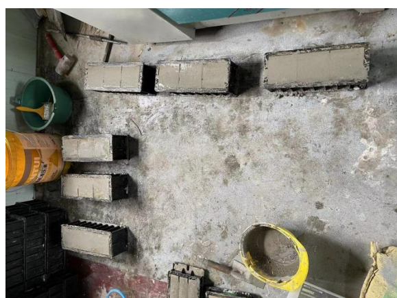
(混凝土试块留置)
