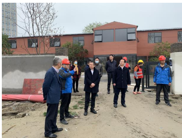
(学校领导视察工地)
