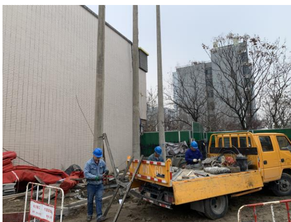
(临时施工临变安装)
