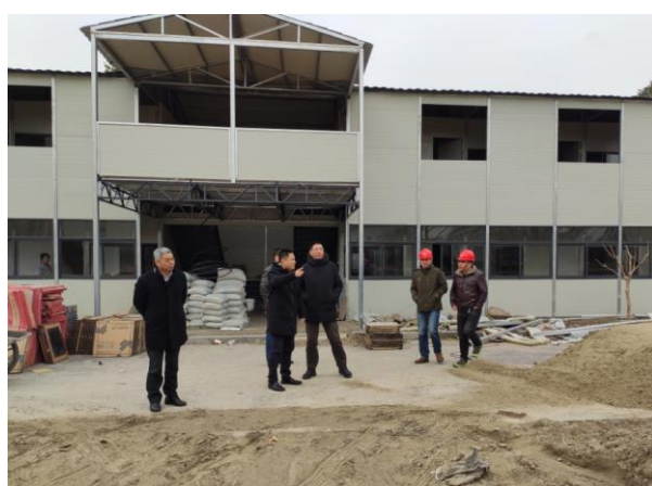
(学校领导视察工地)
