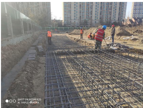
(临时自动清洗水槽施工)
