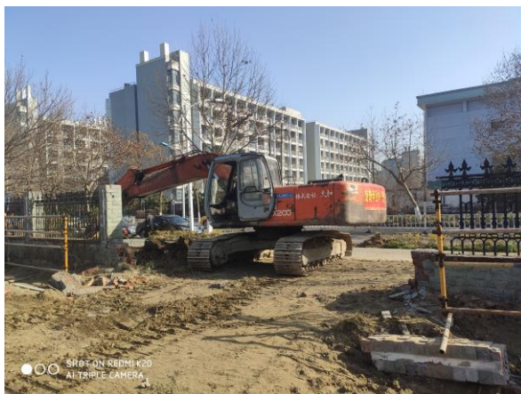
(临时大门施工)
