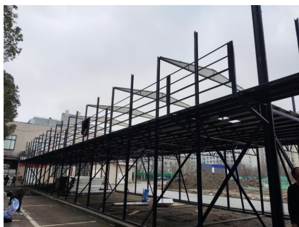
(临时生活板房搭建)
