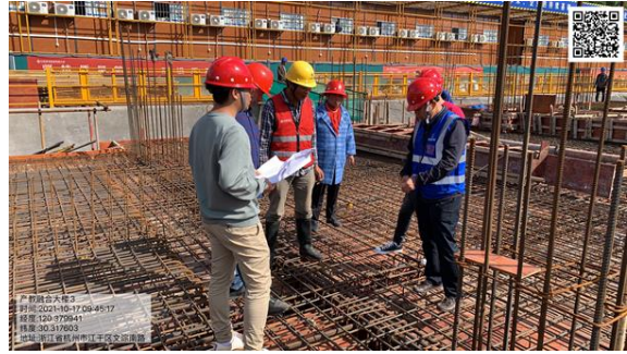
(钢筋隐蔽工程验收)
