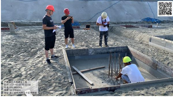
(桩基小应变检测)
