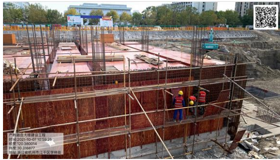
(地下室外墙封模)
