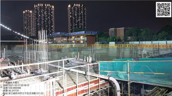
(一区块夜间混凝土浇筑)
