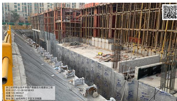
(外墙防水卷材施工)
