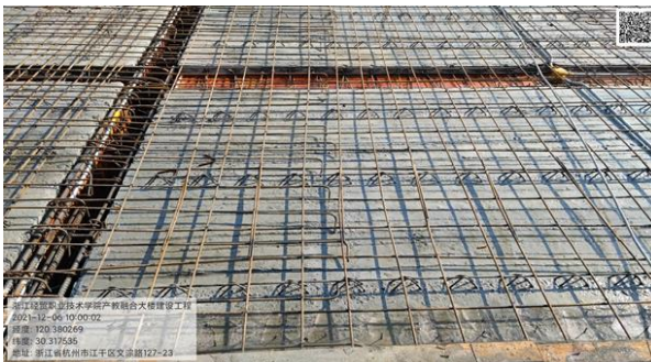
(PC 叠合板面钢筋绑扎)
