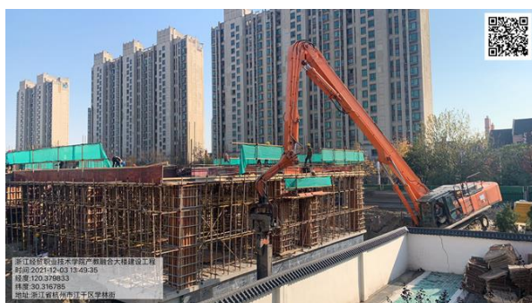
(拉森钢板桩拔除)
