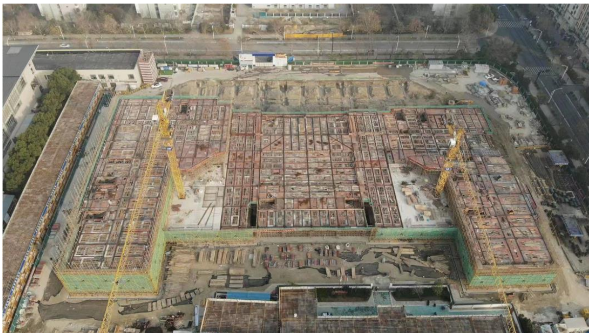
(工程项目全貌 2021 年 12 月 20 日)
