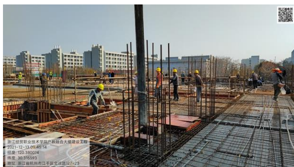
(四区二层混凝土浇筑)
