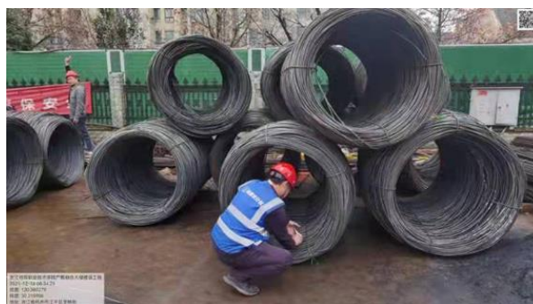
(钢筋原材料进场检查)
