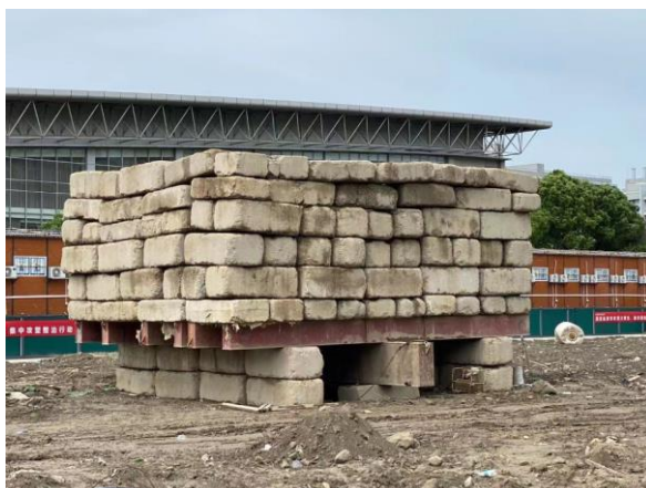
(桩基静载检测)
