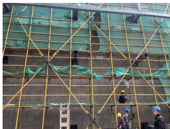
(外墙保温板施工)
