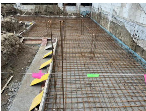
(花坛基础钢筋绑扎)
