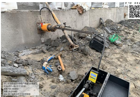
(边坡锚索检测)
