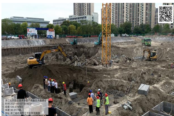
(五方主体地基验槽)
