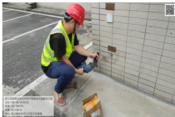
(周边建筑物沉降点观察点安装)
