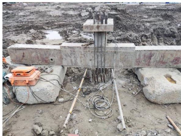
(桩基抗拔检测)
