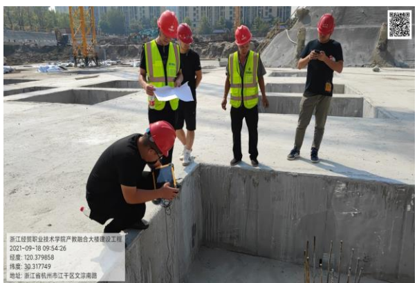
(质安监站桩基小应变检测)
