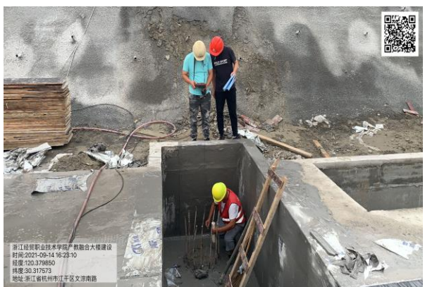
(桩基小应变检测)
