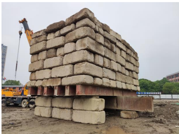
(桩基静载检测)
