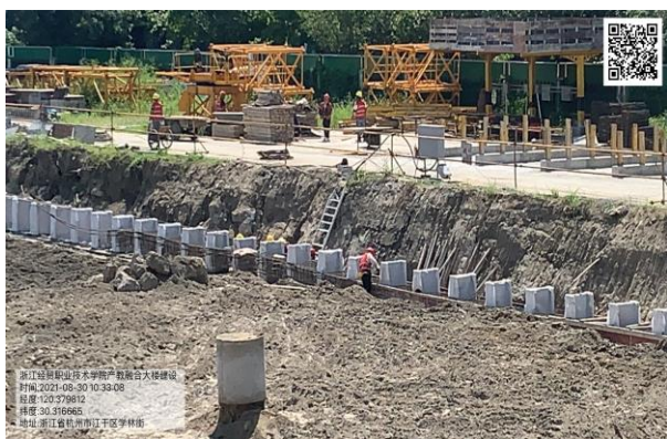
(基坑钢板桩施工)
