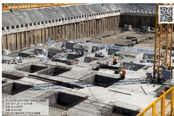
(底板钢筋施工)
