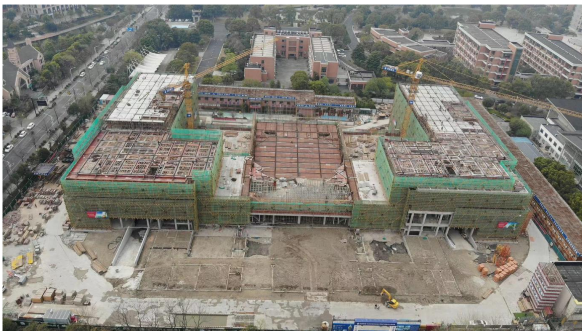
(工程项目全貌 2022 年 3 月 16 日)
