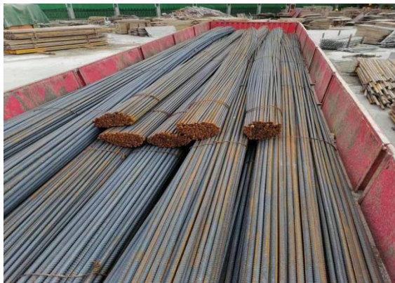
(钢筋原材进场)
