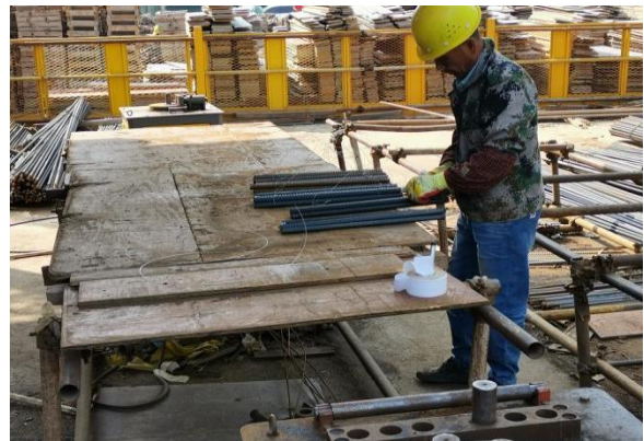
(钢筋原材取样送检)
