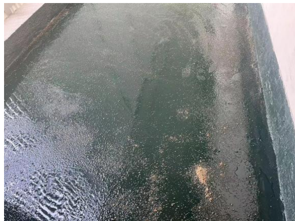
(设备平台防水涂料施工)
