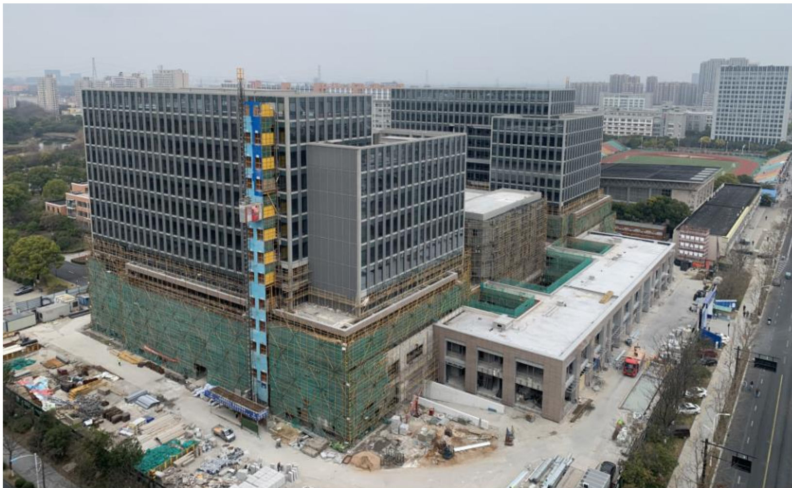
(工程项目全貌 2023 年 2 月 23 日)
