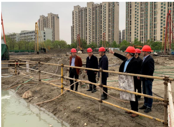
(校领导现场检查)
