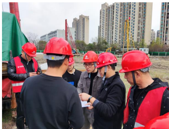
(桩基现场安全检查)
