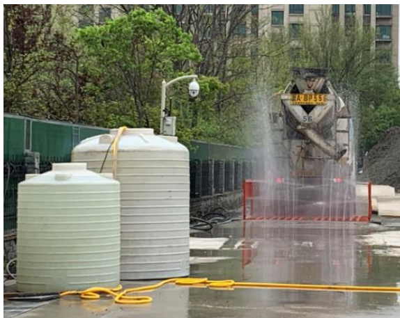
(文明施工设施)
