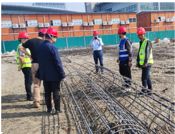
(钢筋笼现场抽查)
