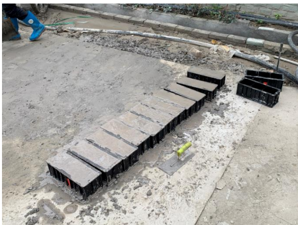
(混凝土试块制作)
