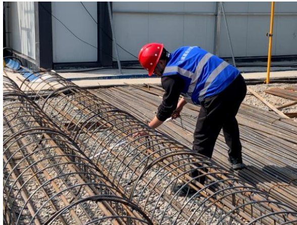
(钢筋笼现场抽查)
