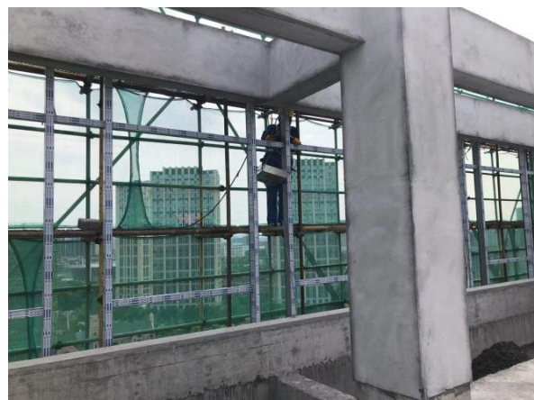
(幕墙龙骨施工)
