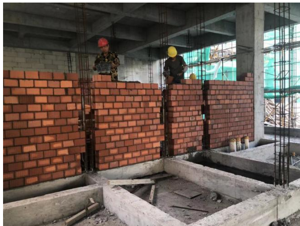
(二次结构砌筑)
