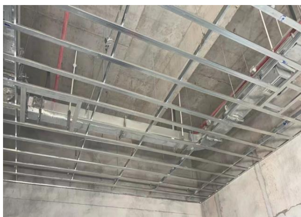
(卫生间吊顶安装)
