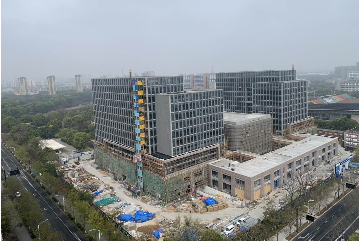
(工程项目全貌 2023 年 3 月 20 日)
