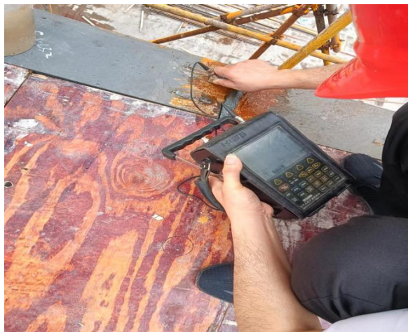
(钢结构焊缝检测)
