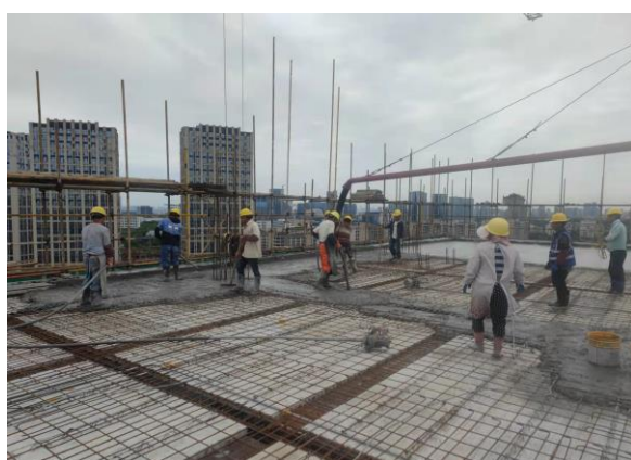
(混凝土浇筑)
