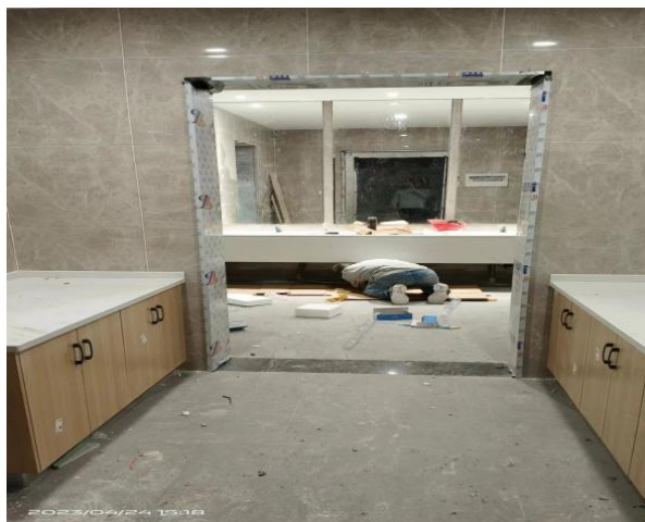
(卫生间样板施工)
