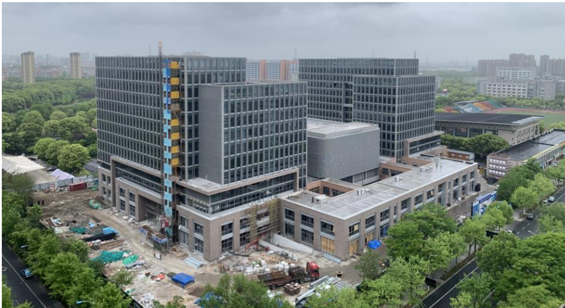
(工程项目全貌 2023 年 4 月 23 日)
