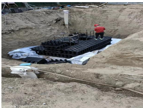
(雨水收集池安装)
