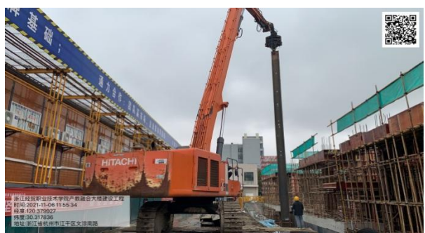
(拉森钢板桩拔除)
