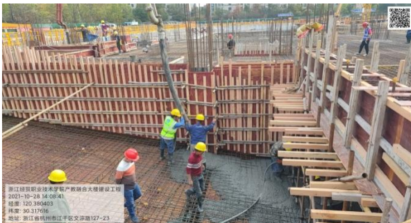
(二区块汽车坡道浇筑)
