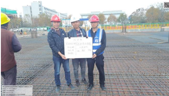
(三区块地下室顶板钢筋验收)
