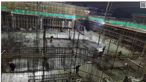
（五区块地下室底板浇筑）
