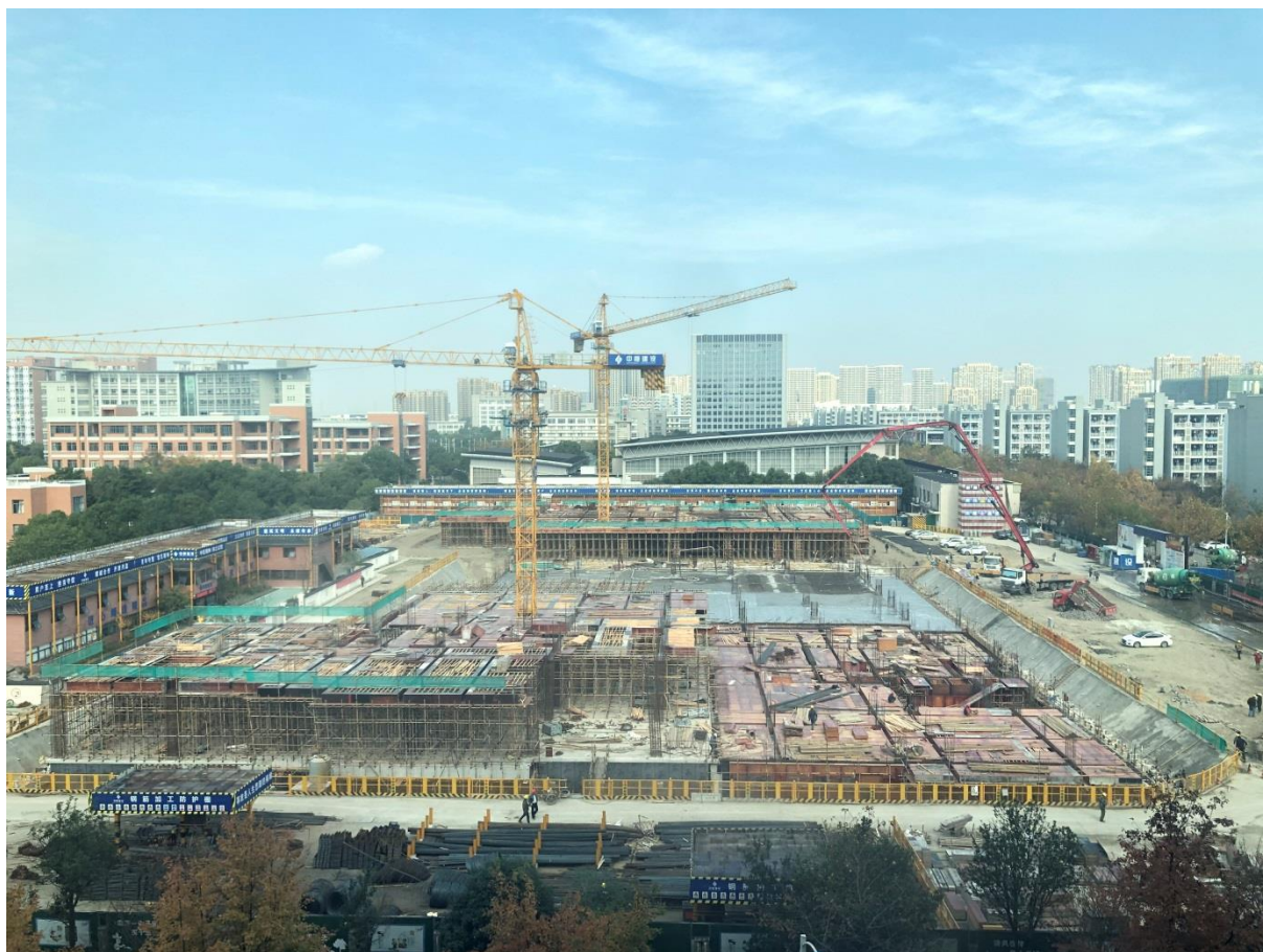
（工程项目全貌 2021 年 11 月 20 日）
