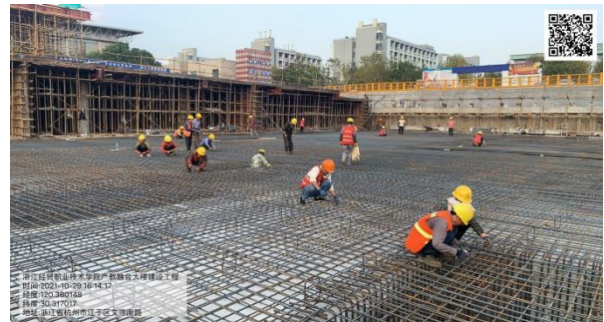
(三区块底板钢筋绑扎)
